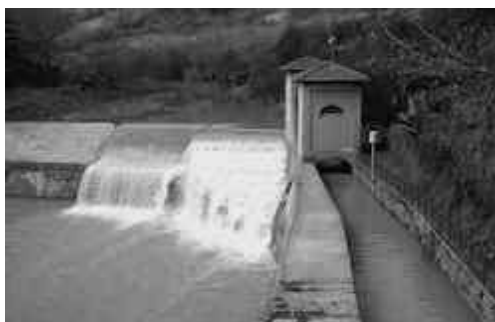
Chiusa sul Savena a San Rufillo
